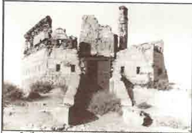
Fortín de la Restinga de Tofiño. Estado Actual
