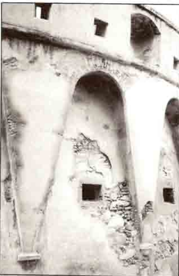
Fuerte de Camellos (Estado Actual). Detalles de los Arcos Parabólicos
