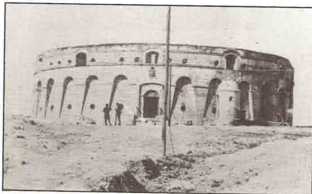
Fuerte de Cabrerizas Bajas (c. 1911)
